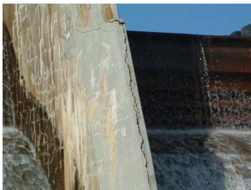
شکل ۱- نمونه‌ای از واکنش قلیایی-سیلیسی در بدنه سد [۸]
