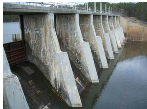
شکل ۱- نمونه‌ای از واکنش قلیایی-سیلیسی در بدنه سد [۸]
